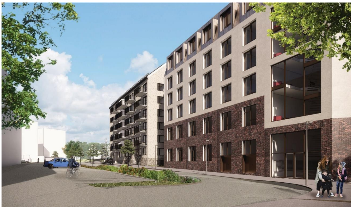
Bild 30. Amastens byggnad, med förskola i två våningar.
